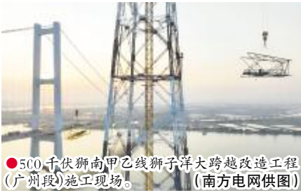
500 千伏狮南甲乙线狮子洋大跨越改造工程(广州段)施工现场。(南方电网供图)
