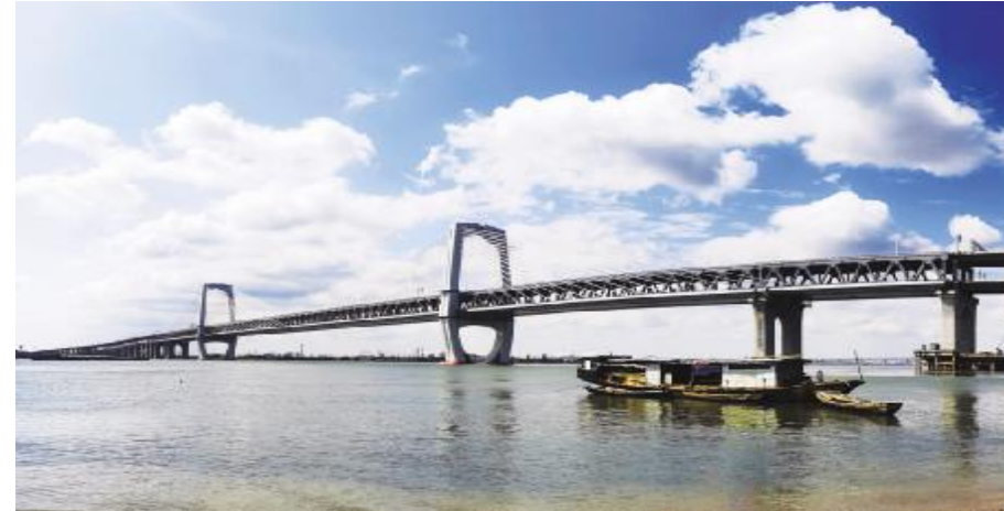
由中铁建电气化局南方公司负责“四电”集成工程施工的商合杭高铁合湖段芜湖长江公铁大桥全景。
