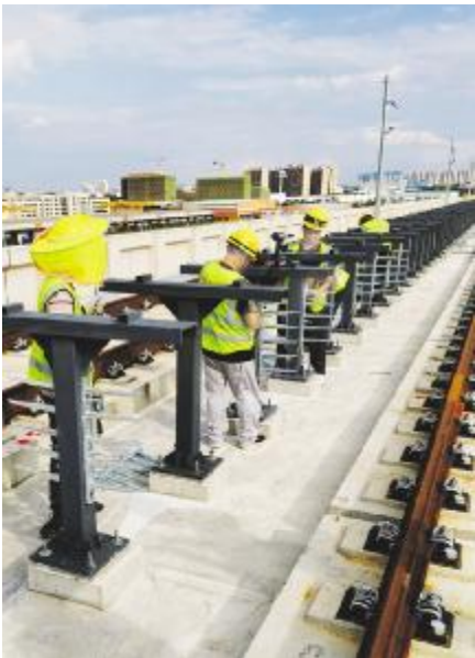
● 2023年9月7日,中铁十一局电务公司项目部员工在金山高架区间安装信号电缆支架。
