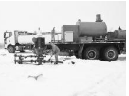
该厂岗位员工正在进行螺杆泵井洗井工作。(程岚 摄)
