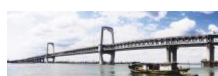
●2020 年 6 月 28 日,由中国铁建电气化局南方公司负责“四电”集成工程施工的长江三角洲区域一体化发展重要通道——商(丘)合(肥)杭(州)高铁开通运营。
