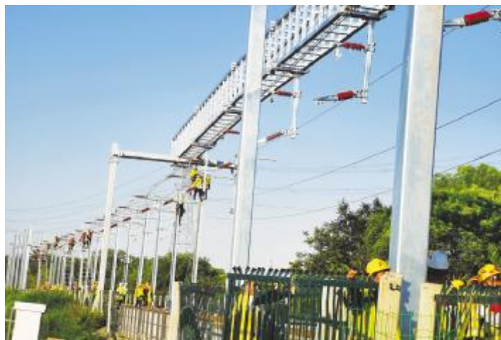
2023年6月22日,端午节,中国铁建电气化局三公司铁科院环线项目员工在安装接触网。
