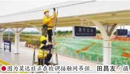
图为莫远旺正在检测接触网吊弦。田昌友/摄
