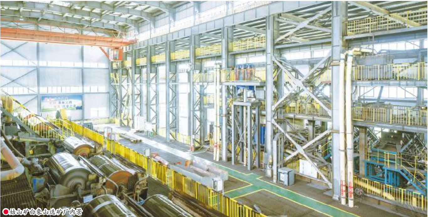
● 姑山矿白象山选矿厂内景
