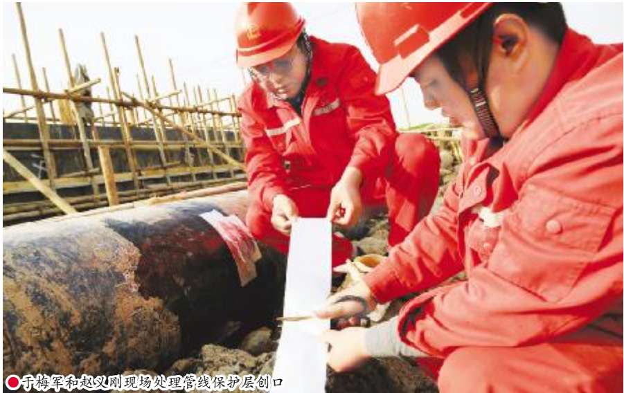
●于梅军和赵义刚现场处理管线保护层创口
