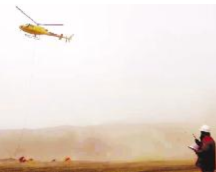
● 直升机开展吊装作业现场
