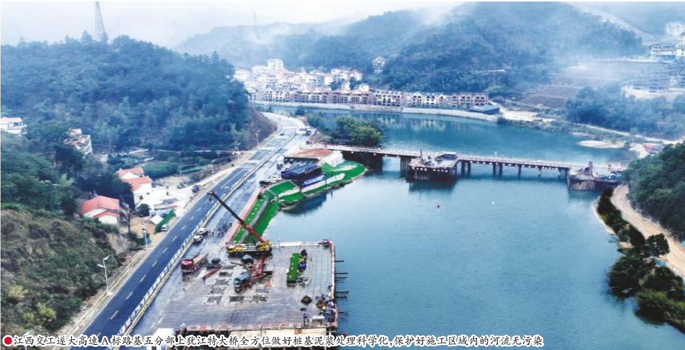
●江西交工遂大高速 A 标路基五分部上犹江特大桥全方位做好桩基泥浆处理科学化,保护好施工区域内的河流无污染
