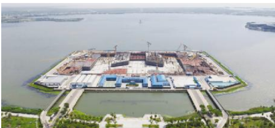
●2022年8月，上海临港西岛金融中心完成地下主体结构施工。
