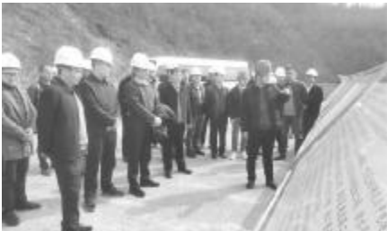
●实地查看工程建设情况
