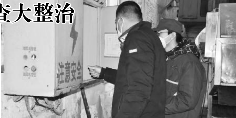
此次检查是全方位、拉网式的安全生产大排查,对各类安全隐患,能立即整改的要立即整改;不能立即整改的,要落实责任、资金、整改措施,限期整改,确保安全生产大检查取得实效。
