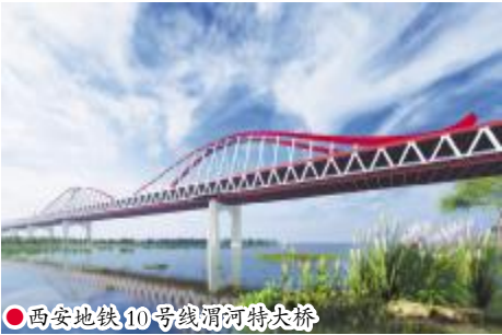
●西安地铁10号线渭河特大桥
