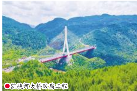
●凯峡河大桥防腐工程
