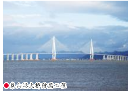
●象山港大桥防腐工程
