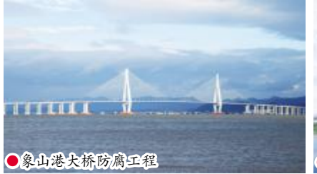
●象山港大桥防腐工程
