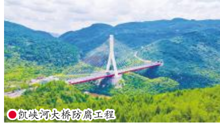
●凯峡河大桥防腐工程
