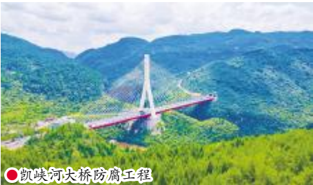
●凯跃河大桥防腐工程
