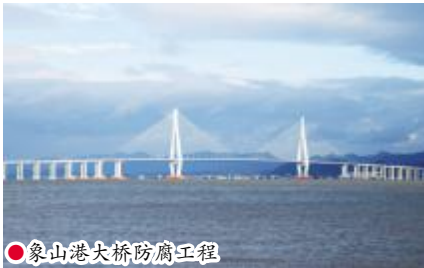
●象山港大桥防腐工程
