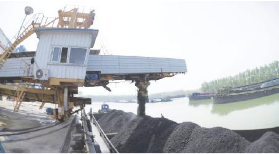
● 济三煤矿泗河口港 1 号泊位
