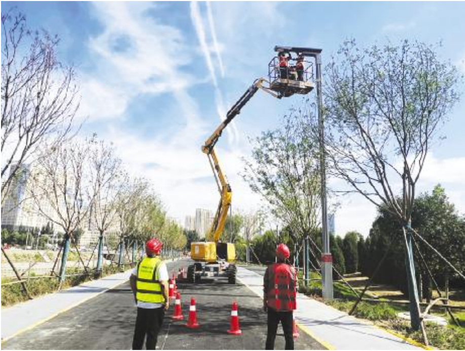
● 2022年9月24日,中国铁建电气化局三公司保定大水系项目员工在安装智慧路灯塔搭载设备。(李康摄)
