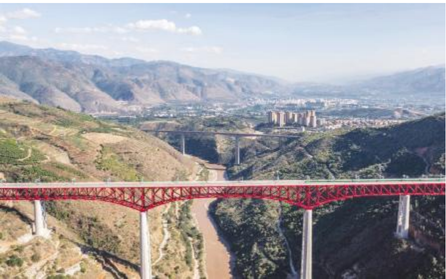
●“复兴号”列车通过中老铁路元江特大桥。
