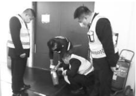
●开展配电房消防安全检查
