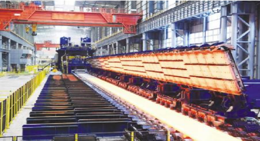
●河北省乐亭经济开发区河钢集团唐钢公司的轧钢车间。 杨世尧 摄
