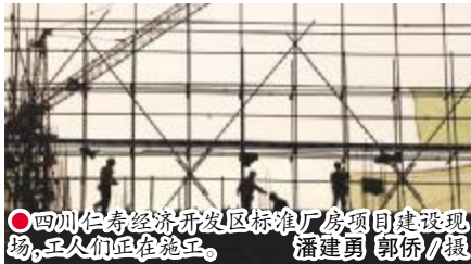
● 四川仁寿经济开发区标准厂房项目施工现场,工人们正在施工。 潘建勇 郭桥 摄
