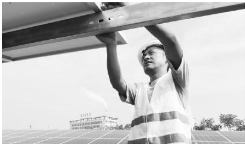
● 光伏项目施工现场
