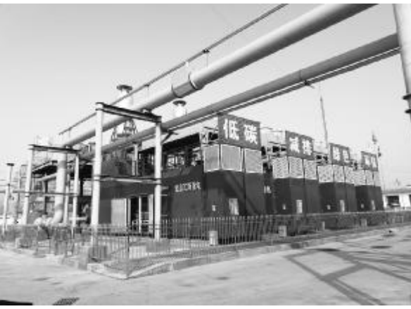
● 图为华电煤业集团山西石泉煤业瓦斯发电项目现场。
