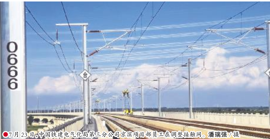
7月23日,中国铁建电气化局第三分公司京滨项目部员工在调整接触网。潘瑞强/摄
