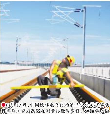
8月19日,中国铁建电气化局第三分公司京滨项目部员工冒着高温在测量接触网参数。潘瑞强/摄
