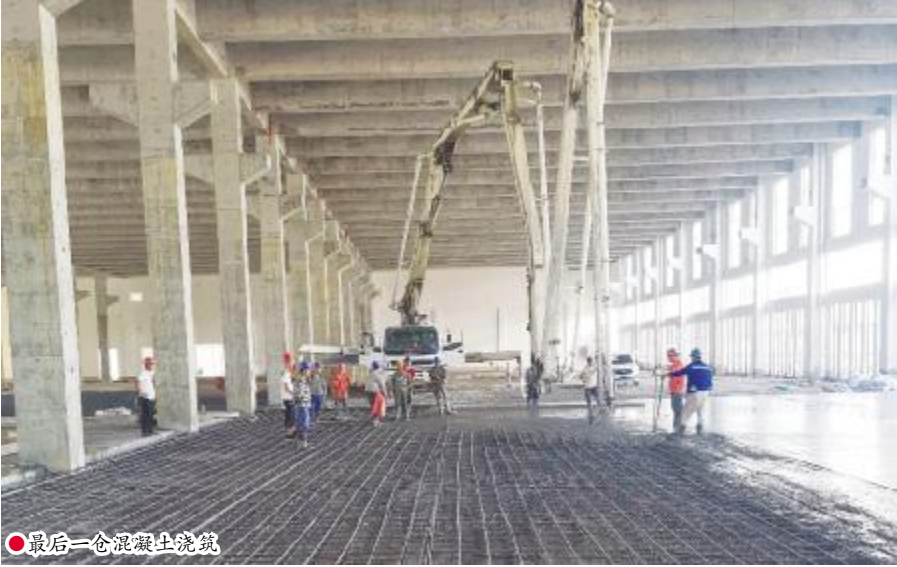
●最后一仓混凝土浇筑
