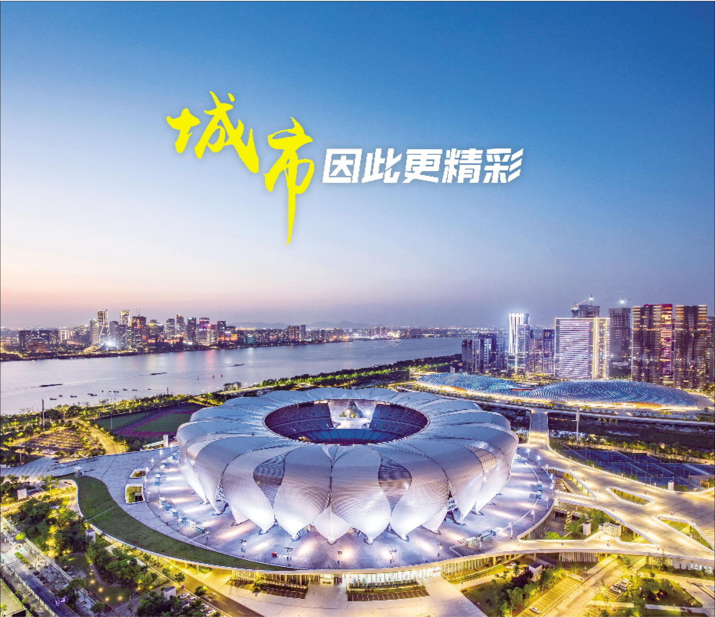
● 滨和集团承建的杭州奥体中心亮灯工程
