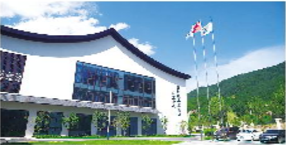
● 滨和集团—富阳区易腐垃圾处置中心
