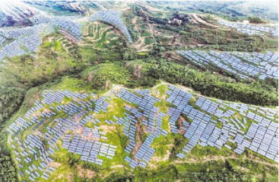
●这是8月4日在河南省济源市大峪镇拍摄的一处光伏电站。
