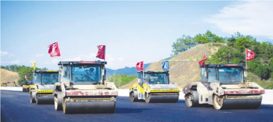
●压路机在平益高速路面建设现场作业。
