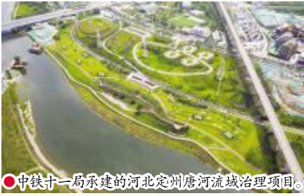
○中铁十一局承建的河北定州唐河流域治理项目。
