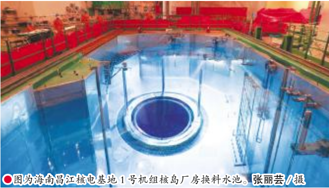
●图为海南昌江核电基地1号机组核岛厂房换料水池。张丽芸/摄
