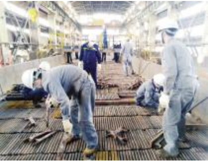
●该作业区甲班职工正在1号烧结机检修现场更换烧结机台车炉篦条。何勇/摄
