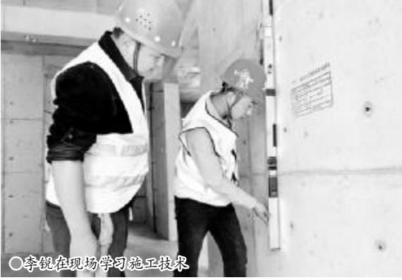
●中铁二十三局集团莒南房建项目施工现场
