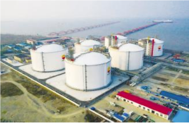
●位于南通洋口港阳光岛的 LNG(液化天然气)储罐。
