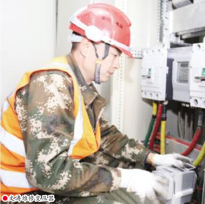
●文涛维修变压器
