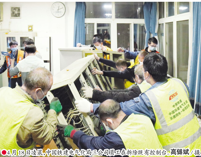
4月18日凌晨,中国铁建电气化局三公司职工在拆除既有控制台。 高健斌/摄
