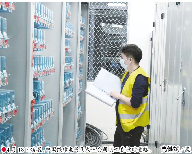
4月18日凌晨,中国铁建电气化局三公司职工在核对进路。 高健斌/摄
