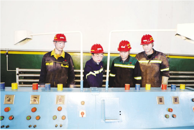
●机电大拿李东升手把手教徒弟检修真空电磁启动器
