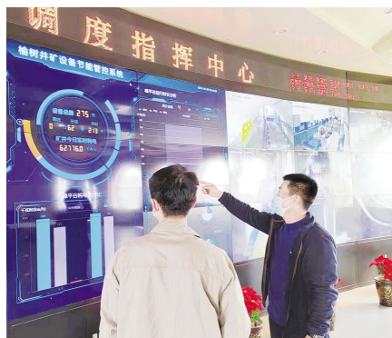
榆树井煤矿集控调度中心
