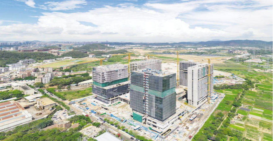
●深圳光明科学城启动区工地建设现场。
