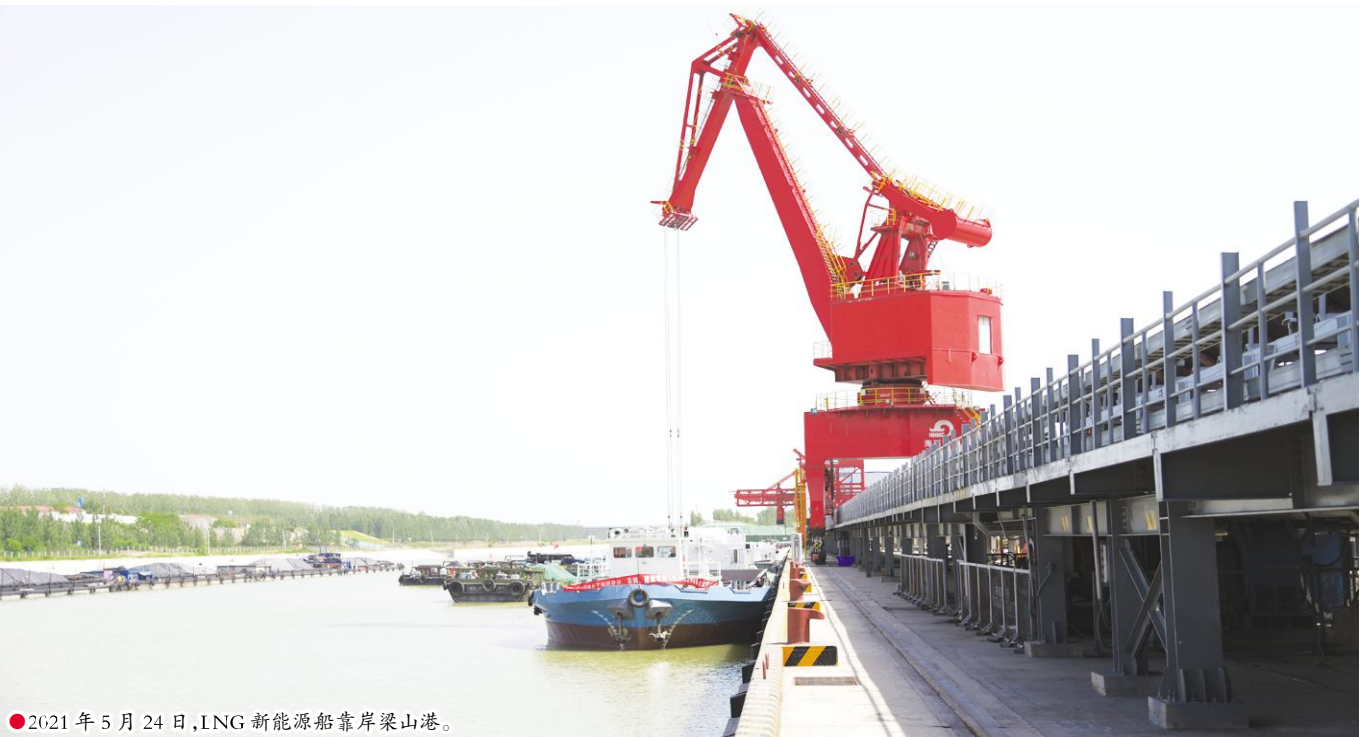
●2021 年 5 月 24 日,LNG 新能源船靠岸梁山港。
