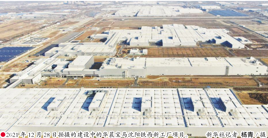
● 2021 年 12 月 28 日拍摄的建设中的华晨宝马沈阳铁西新工厂项目。新华社记者 杨青/摄
