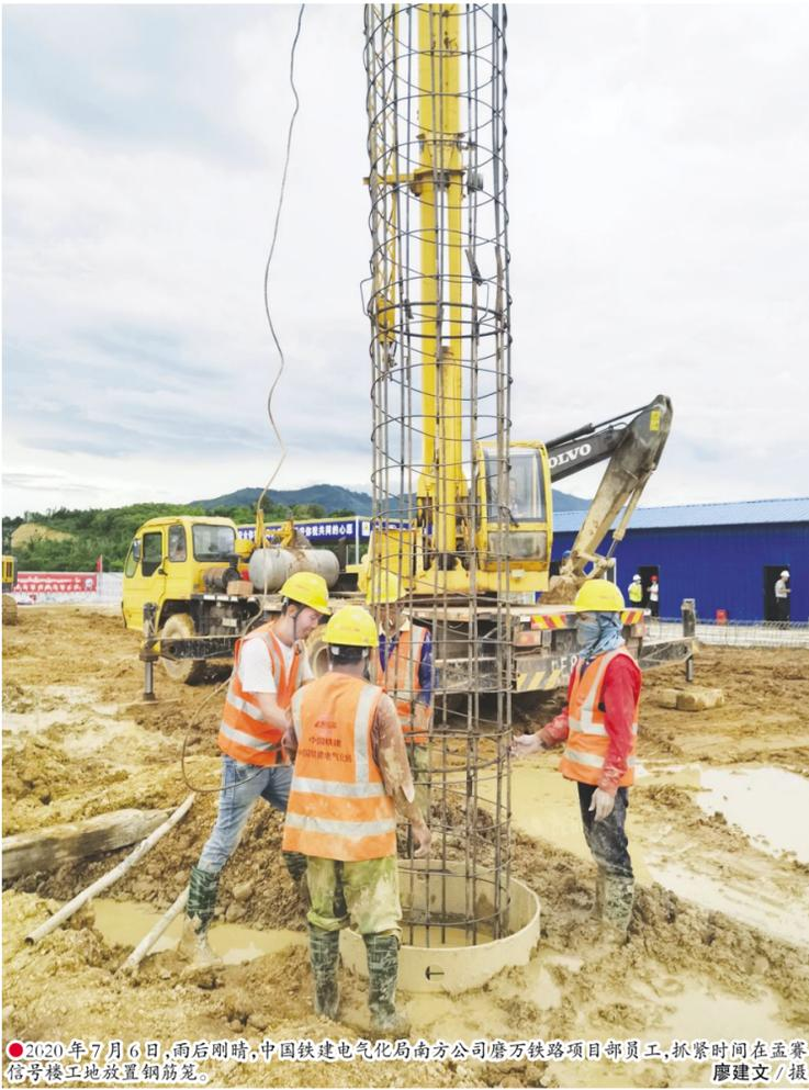
2020 年 7 月 6 日,雨后初晴,中国铁建电气化局南方公司磨万铁路项目部员工,抓紧时间对孟赛信号楼工地放置钢筋笼。
