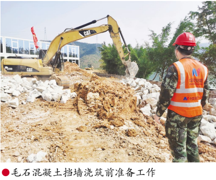
●毛石混凝土挡墙浇筑前准备工作
