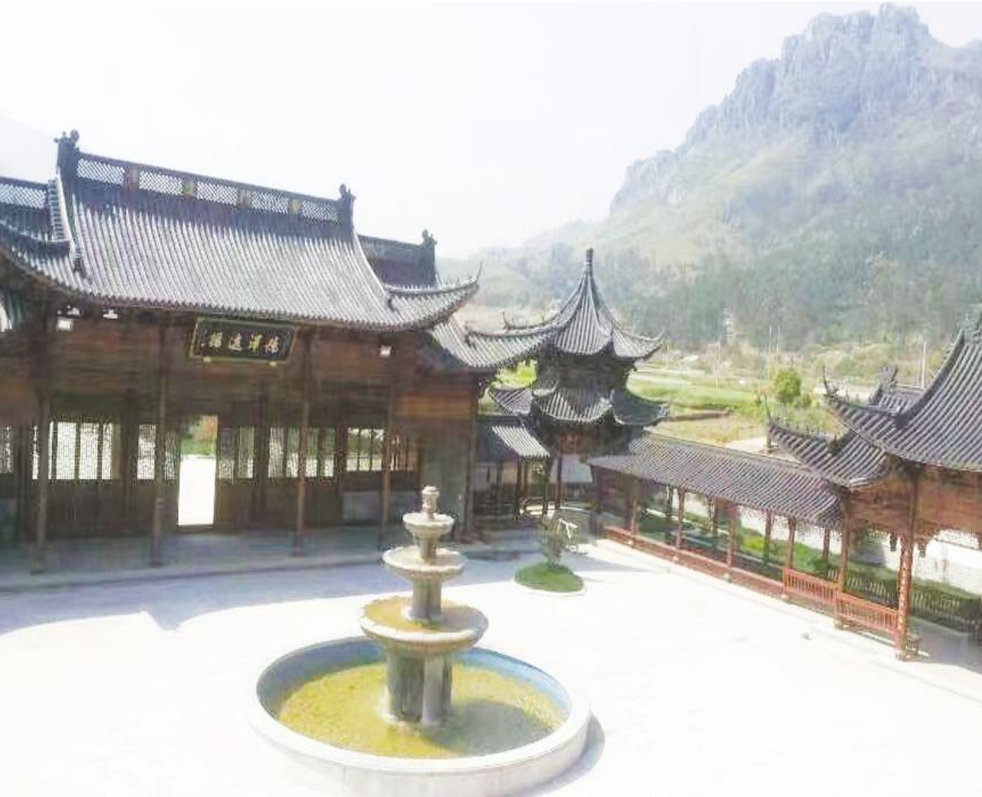
●中国(林学泰斗)陈嵘纪念馆工程
