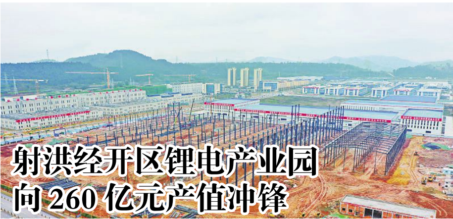
● 富临新能源科技有限公司二期项目建设现场。
