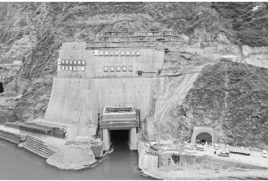
●金川项目导流洞进水塔施工全景
