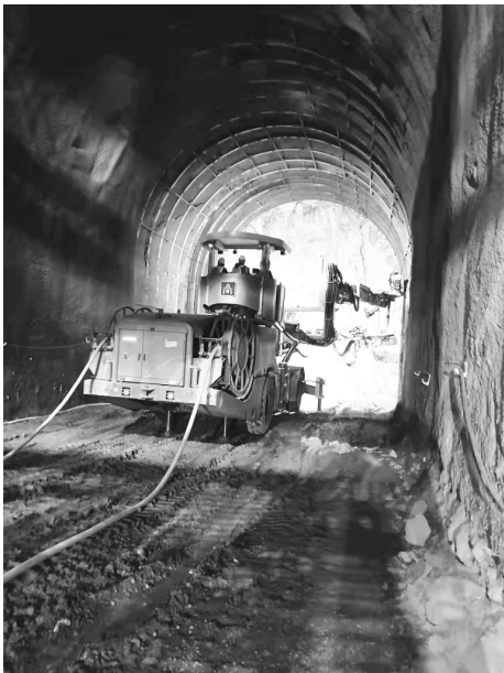
●HN 库区地下工程项目正在进行多臂钻钻孔施工
