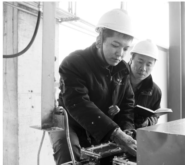
●安全督查小分队正在进行隐患排查。
