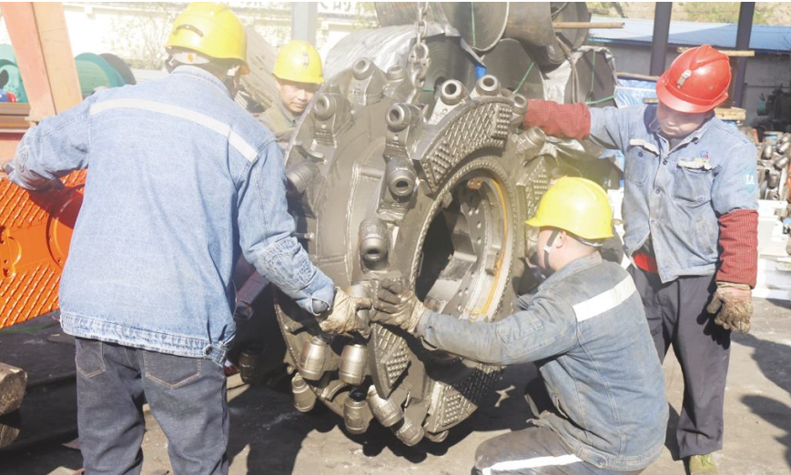
赵家坝煤矿综采地面试运转
