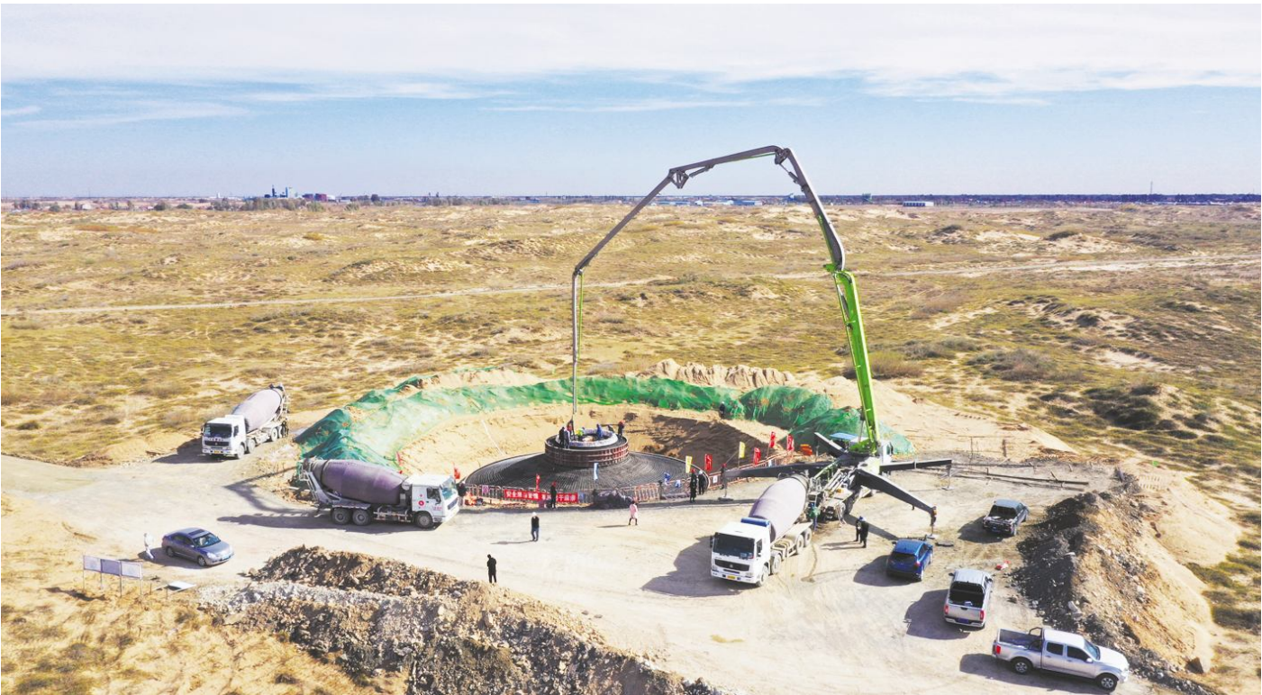
●全国首个“火、风、光、储、制、研一体化”示范项目明阳智慧能源施工现场
