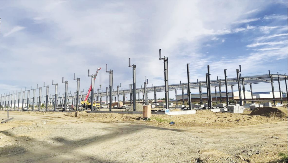
●通辽原谷农业科技绿色农产品深加工项目建设中。
