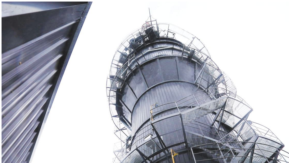
●源怡能源生物质热电联产项目并网发电,脱硫塔投入作业。
