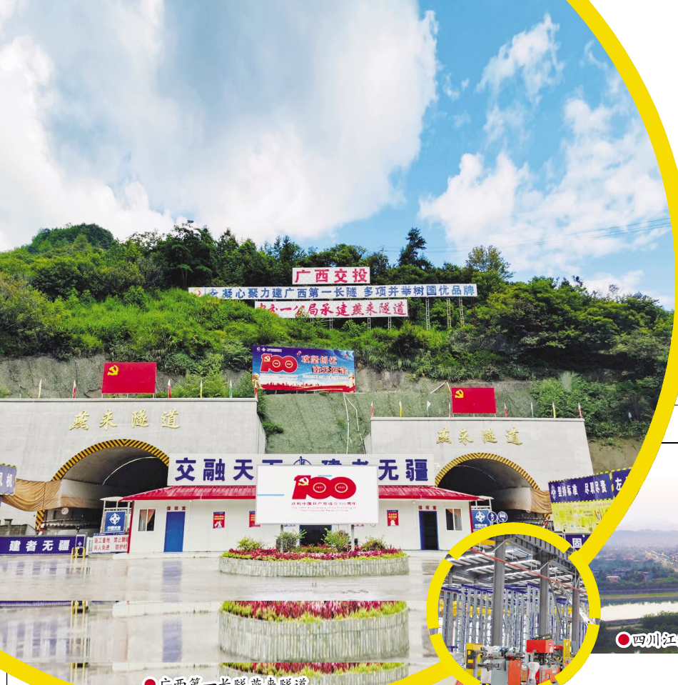
广西第一长隧燕来隧道。
