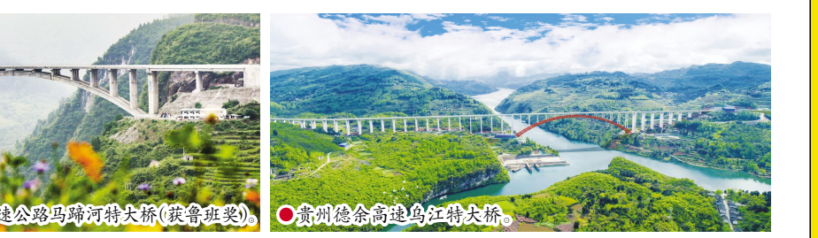
中国高速公路第一桥独柱桥公路马河特大桥(优青项目)。
